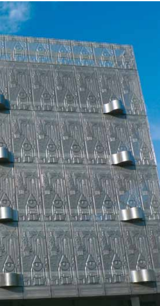
Parkhausverkleidung aus Lochblech im niederländischen Almere
